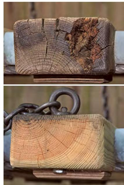
Abb. 44: Negatives Beispiel: Verwendung von Kern- und Splintholz; die Reparatur erfolgte wieder mit einem Bauteil mit nicht dauerhaftem hohem Splintholzanteil; Befall mit Gallerträne (*Dacrymyces sp.*).
