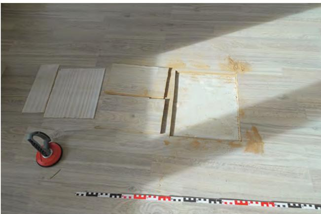
Abb. 5: Bauteilöffnung
