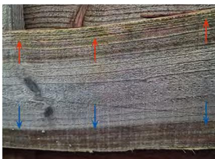
Abb. 33: Kiefernholz eines Bretterzauns im Regen – Splintholzanteile feuchten sichtbar stärker auf, nicht nur die obere Seite wird im Regen nass (blaue Pfeile); das Splintholz ist verblaut und auf der oberen Seite beginnen Algen zu wachsen (rote Pfeile).
