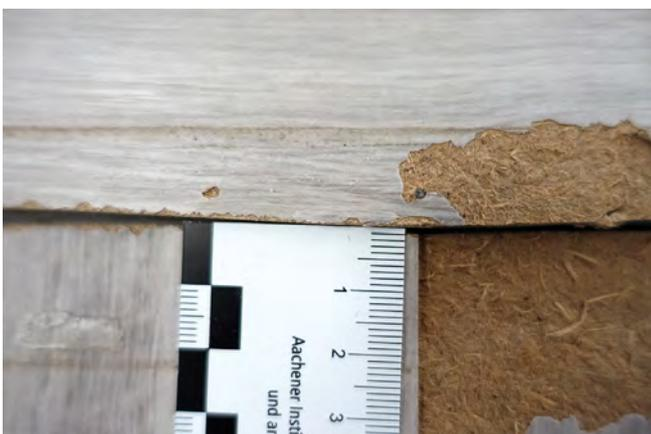
Abb. 6: Stoß des Laminatbelags im Türdurchgang
