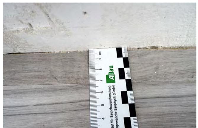
Abb. 7: Randfuge zu den aufgehenden Wänden: 0 mm
