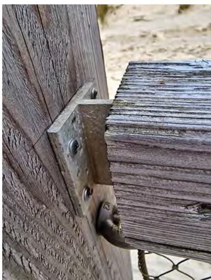
**Abb. 46:** Teil einer Absturzsicherung: Bauteil-Endkoppelung, zwischen Querholz mit Netz und Ständer; Wasser-Fallen werden vermieden
