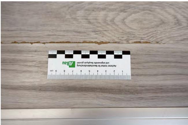
Abb. 3: Abplatzungen an den Stößen
