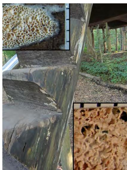
**Abb. 40:** Flach anliegende Fruchtkörper des Veränderlichen Spaltporlings (*Schizopora paradoxa*) an einer Steighilfe; Befall des Splintholzes und auf der dritten Stufe auch schon Fruchtkörper im Kernholz; Eckbilder: Variation der Poren (oben) bzw. Zähnchen (unten) in den Fruchtkörpern
