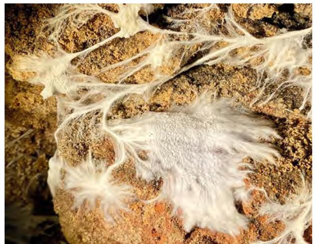
Abb. 1 und 2: Eisblumenartige, weiße Stränge, Myzel mit Fruchtkörper an Mauerwerk
