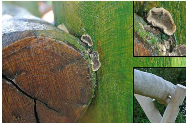
**Abb. 31:** Geländer-Anschluss: Pilz mit mäßiger Fähigkeit zum Kernholzangriff: Initiales Befallsbild ohne erkennbare Weißfäule an einem Robinien-Rundholz mit Wasserfalle, verursacht durch den Eichen-Schichtpilz (*Stereum gausapatum*; vgl. Abb. 32); Fruchtkörper, ca. 2 cm hoch; oberes Eckbild: Detail des Fruchtkörpers; unteres Eckbild: Möglichkeit zur Trennung von Holz-an-Holz-Verbindungen.
