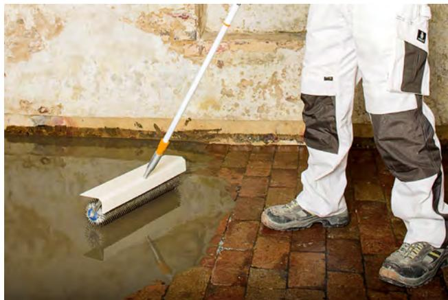
Abb. 6: Bestandsbodenabdichtung bei W1-E
