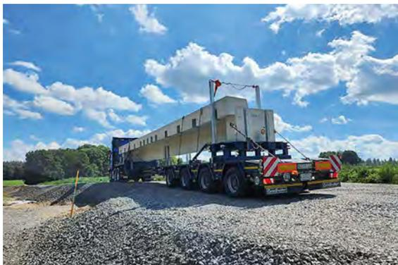
Anlieferung eines Brückenträgers mit einem Tieflader
