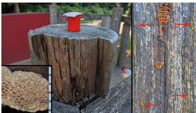
**Abb. 45:** Links: Unterlassene Reparatur einer Ständerabdeckung hat zu einer starken Braunfäule an einem massiven Pfeiler geführt, verursacht durch eine Braunfäuletrame (*Antrodia sp.*); rechts: Millimeter-Maßstab; rechts: Nadelholz-Zaunbrett ca. 2 cm dick (mindestens 15 Jahre alt und ohne baulichen Holzschutz) mit Schäden durch Tannenblättling (*Gloeophyllum abietinum*) und Zerfließende Gallerträne (*Dacrymyces stillatus*, Pfeile). Eckbild (links): kleiner und weißer Fruchtkörper mit Poren.
