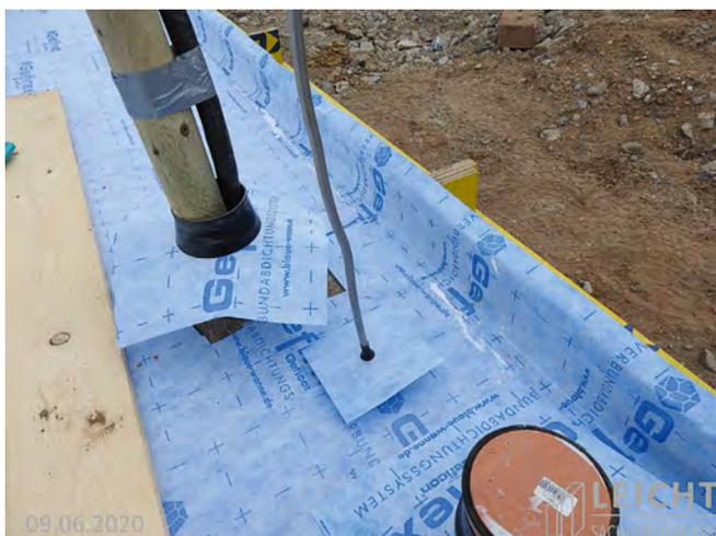
Abb. 3: Vorgerüstete Klebe-Dichtmanschetten für unterschiedliche Durchdringungen
