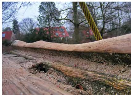
Abb. 43: Bauteil am oberen Ende einer schrägen Kletterwand mit starkem Verschleiß
