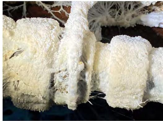
Abb. 3: Ummantelte Wasserleitung mit Fruchtkörper
