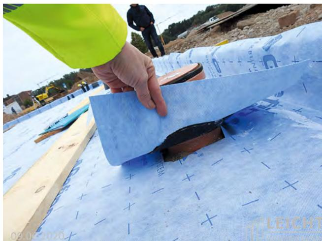
Abb. 4: Vorgerüstete Klebe-Dichtmanschetten für unterschiedliche Durchdringungen
