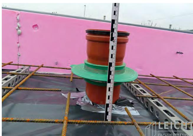
Abb. 6: Einbaubeispiel Mauerkragen
