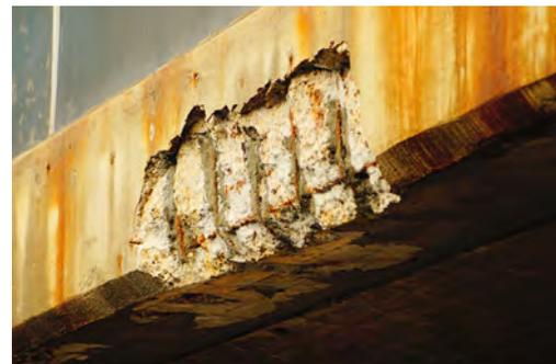
Betonabplatzung an einer Brücke (Foto: AdobeStock / Kay Gebauer/Wirestock)
