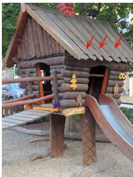
**Abb. 47:** Die Brettstöße sind am Dach abgedeckt (rote Pfeile); trotzdem können besondere Klimate zu Schäden führen; Verschleißteile werden ersetzt (blauer Pfeil); die Wände sind nach außen geneigt; die Fugen am Dach sind dekorativ abgedeckt.
